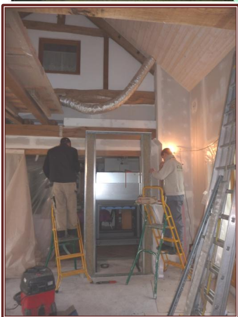
L'armature support du coffre est montée autour de l'insert (Novembre 2013)
