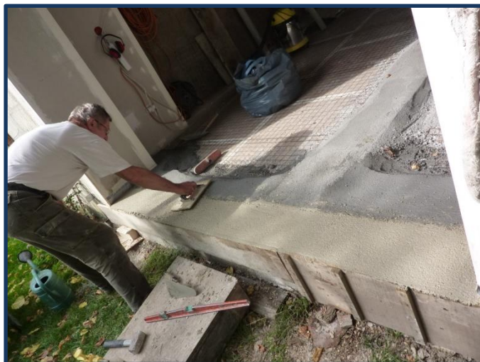
Réalisation de l'avancée de la future baie coulissante (octobre 2013)
